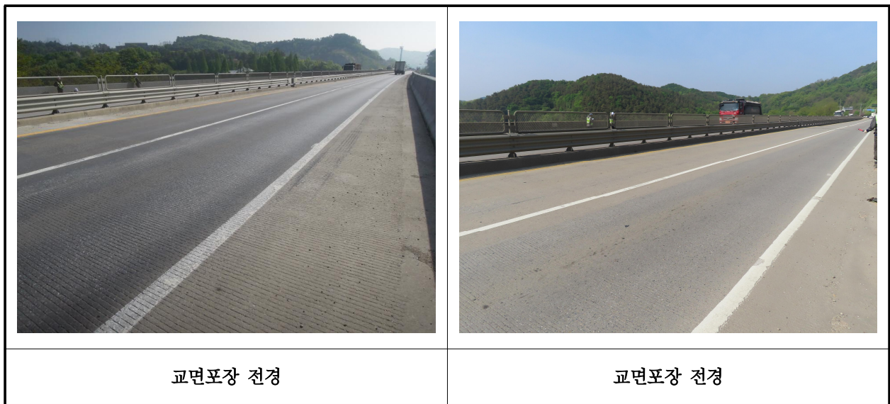
【사진 3.3.16】 교면포장 전경
