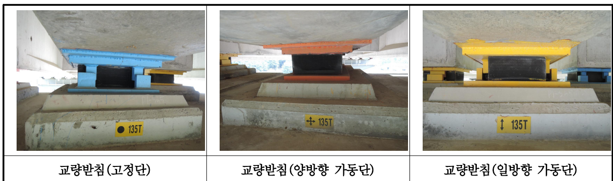
【사진 3.3.11】 교량받침 전경
