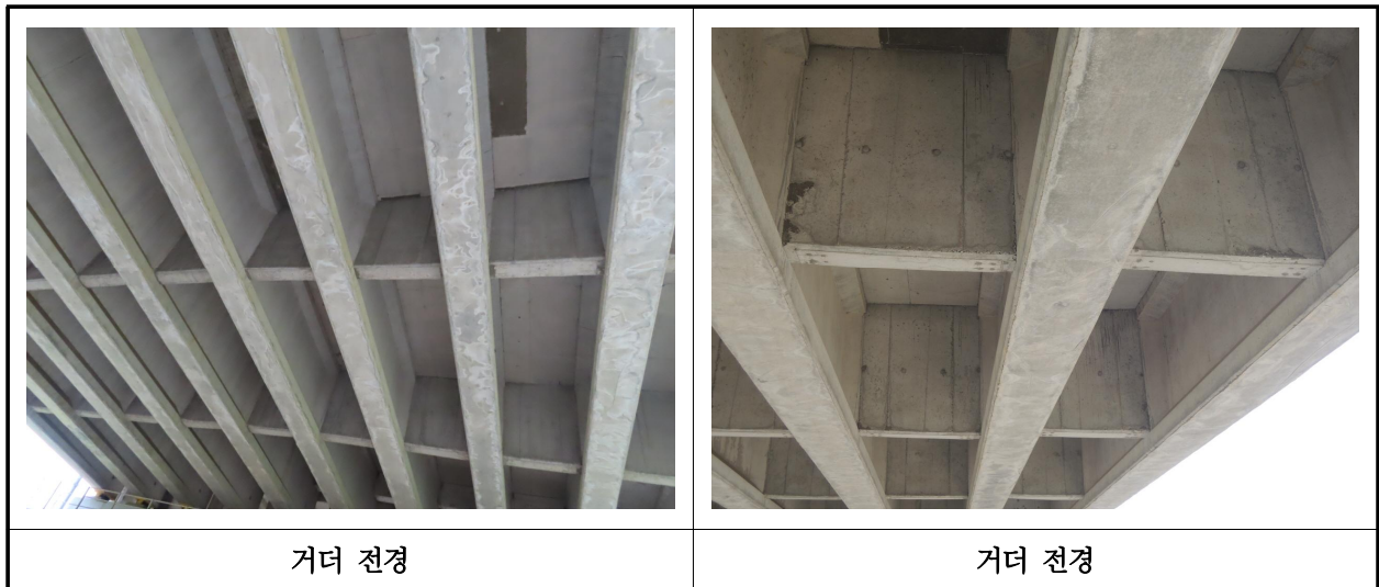
【사진 3.3.4】 거더 전경
